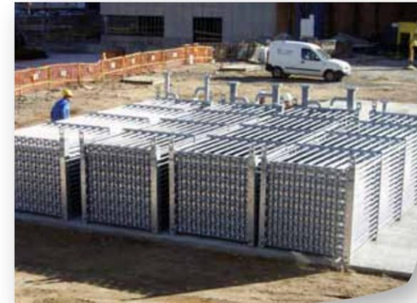
Figura 3. Baterías de acumulación de hielo (Districlima)
