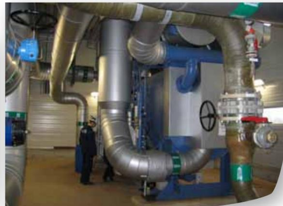
La diferencia de inversión inicial por unidad de potencia instalada, así como de rendimiento entre ambos tipos de equipos es muy grande y haría inviable una instalación con máquinas de absorción frente a otra de compresión mecánica; pero la gran ventaja que presentan los equipos de absorción es que permiten el uso del calor residual o el procedente del uso de energías renovables (sin coste y, sobre todo, sin emisiones asociadas), con lo que se consigue que sea una tecnología competitiva.
