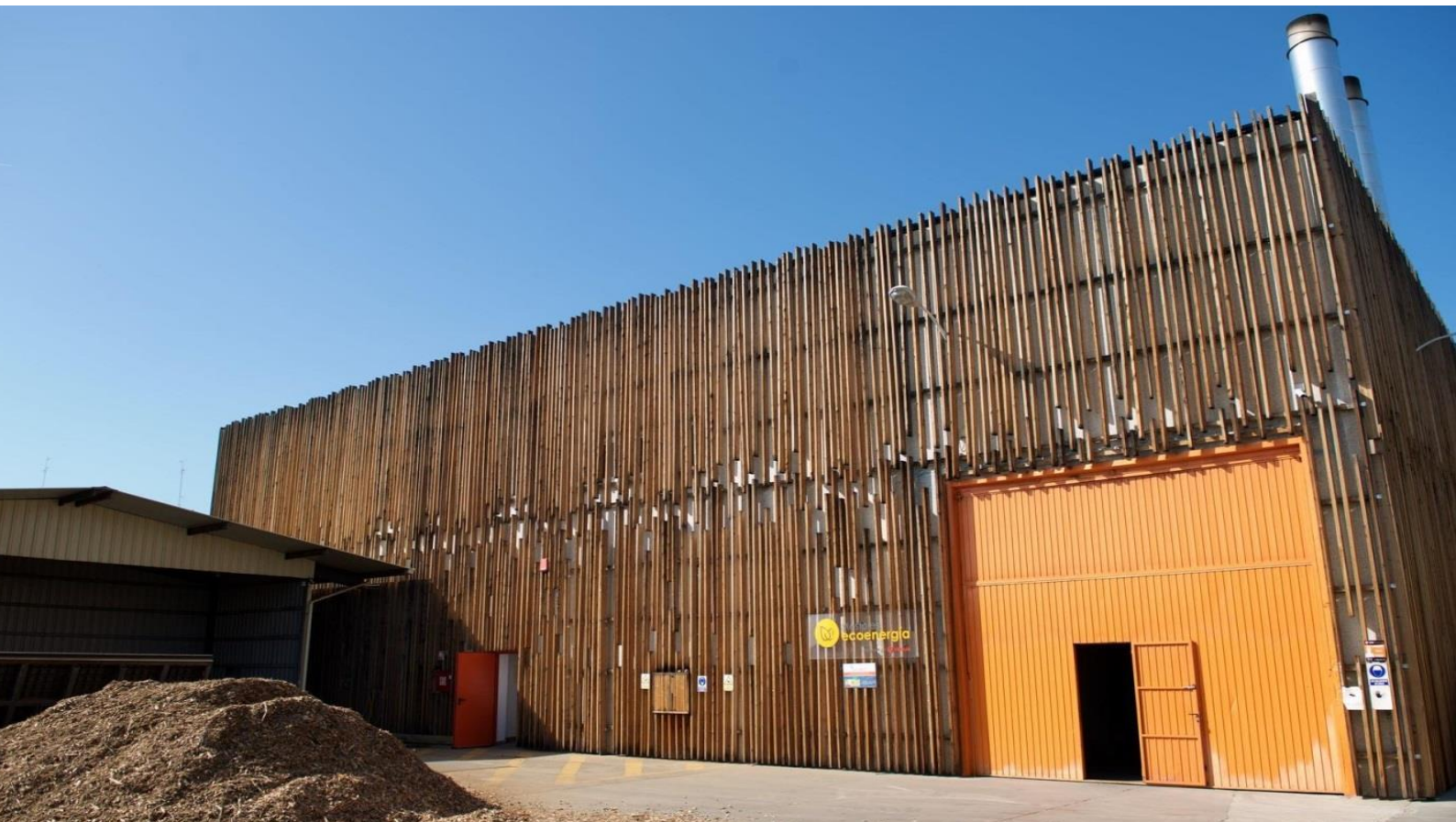
Subcentral de la red de calor Móstoles Ecoenergía, en Móstoles, Madrid
