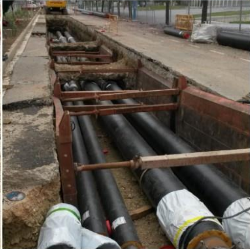
Trabajos de obra civil de red de calor y frío
