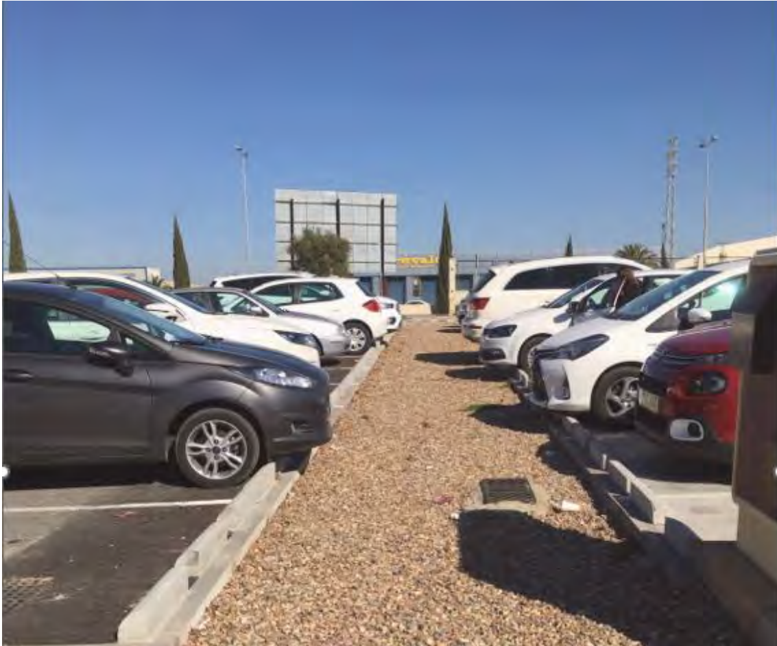
Figura 6.22 Zanja de infiltración en Alcalá de Guadaira (Sevilla). Fuente: EMASESA
