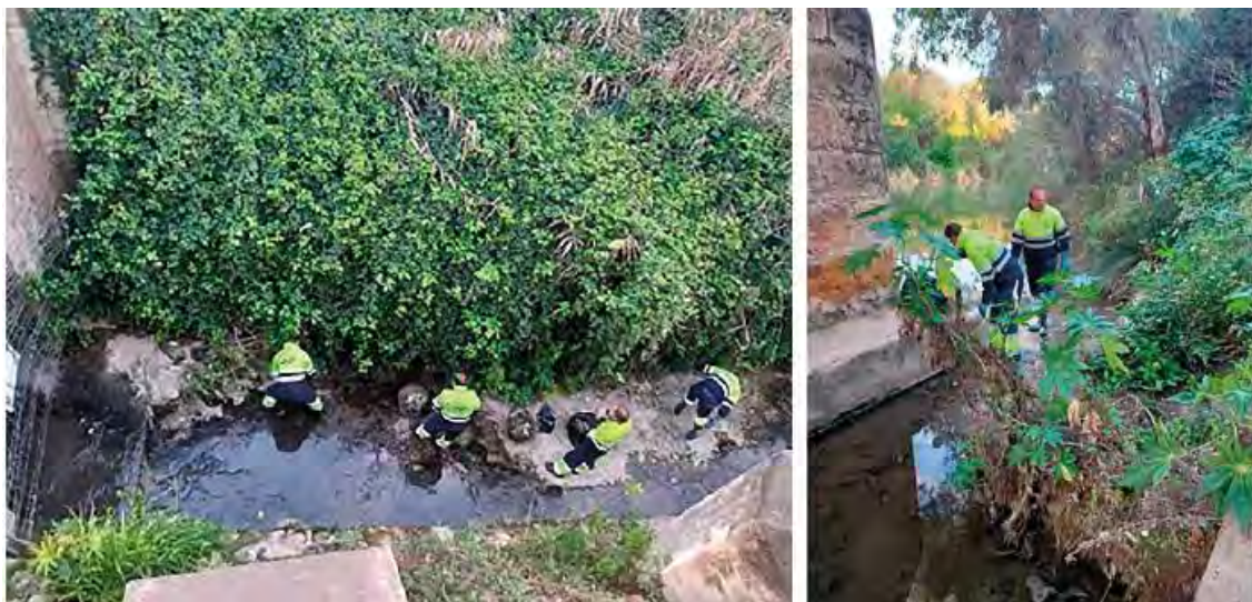
Figura 6.9: Limpieza de ribera tras un VDSS (acción correctiva). Fuente: EMASESA
