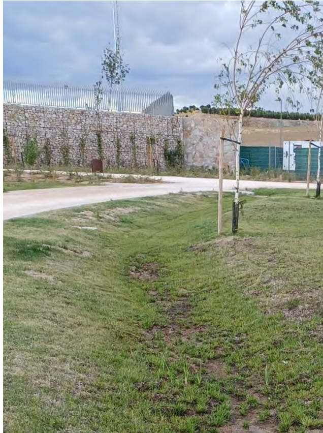
Figura 6.17 Cuneta vegetada en el nuevo Parque Ferial de Fuenlabrada (Madrid). Fuente: Green Blue Management (Grupo TYPESA)
