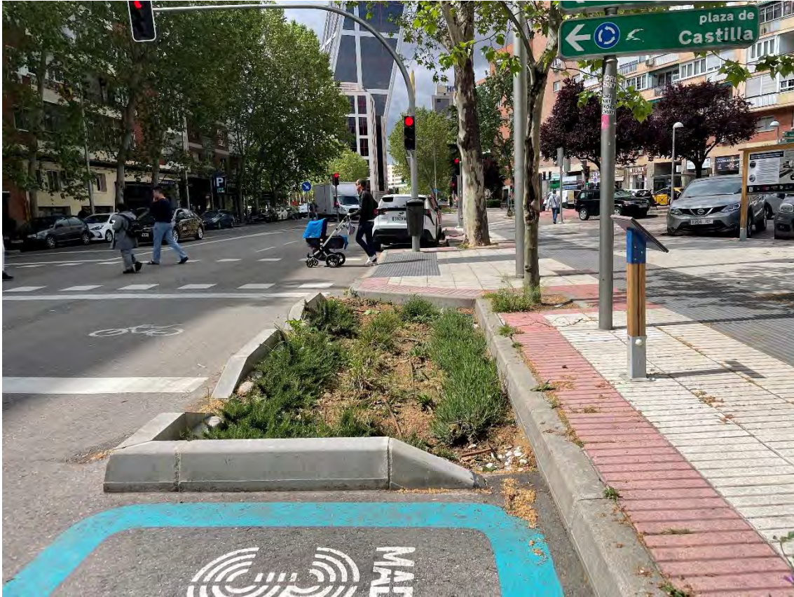
Figura 6.15 Área de biorretención en la calle de Agustín de Foxá (Madrid). Fuente: Ayuntamiento de Madrid.
