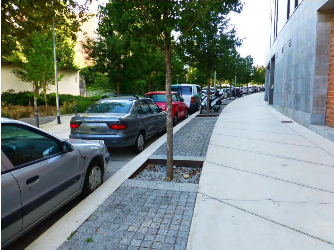
Figura 6.18 Alcorques estructurales en el barrio de Can Cortada (Barcelona). Fuente: Roberto Soto-Instituto Municipal de Urbanismo, Ayuntamiento de Barcelona
