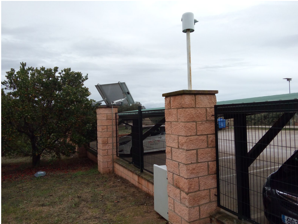
Finca La Cocosa. Instalación de MiNio (Meteo Nano Observatory)
